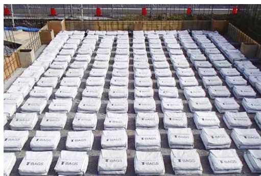
施工イメージ
