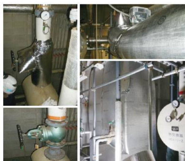
⑤ 都内・大型商業施設 ▶ ボイラー室蒸気配管保温工事
