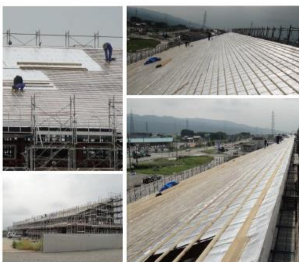
① 北陸地方・道の駅 ▶ 屋根遮熱・壁面断熱工事
