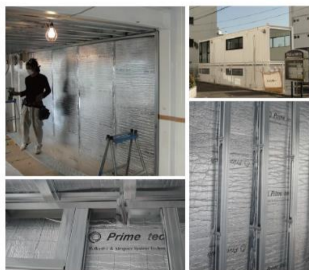
② 都内・コンテナハウス商業施設 ▶ 壁面断熱工事
