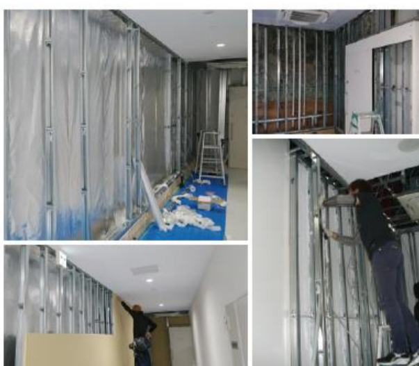
④ 東北地方・水産加工工場 ▶ 壁面断熱・防カビ対策工事
