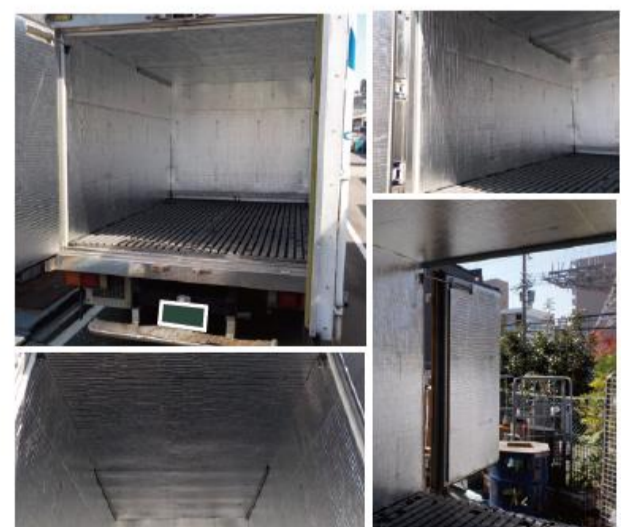
⑥ 関西地方・食品輸送トラック ▶ 荷室内の断熱・遮熱工事
