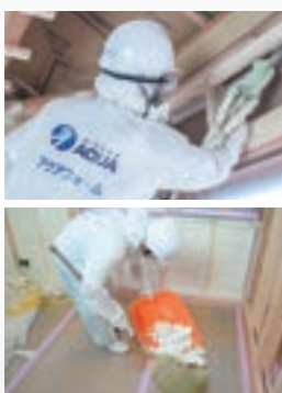
現場施工・端材回収
