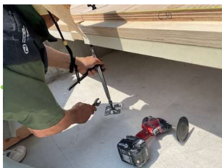
⑧ 鋼製束ナット締め
