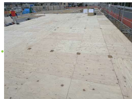
⑨ 楽ダンパネル施工完了
