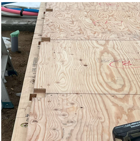
土台載せ施工例
