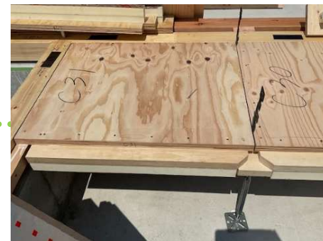
⑥ 楽ダンパネル施工
