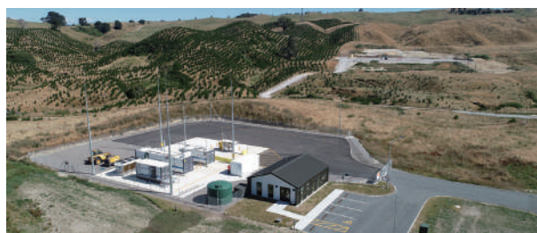
地熱による電力を使用する水素製造プラント（ニュージーランド タウボ） 写真提供：株式会社大林組
