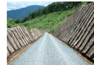
植生基材吹付(風張り) 写真提供: 出光興産株式会社
