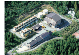
上の岱地熱発電所 写真提供: 東北自然エネルギー株式会社
