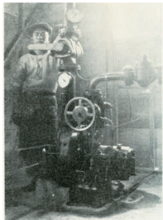
地熱利用第一発電所内におけるタービン、ストレーナーおよび排気管（1925年12月28日撮影）
