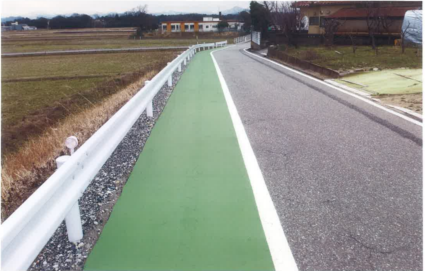
石川県加賀市地内通学・通園路
