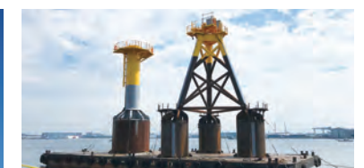
サクシオンバケット基礎(着床式) バケットと呼ばれる円筒形状をした海底に定着させる型式の基礎。バケット内の水をポンプにより排水することで海底に貫入させる。逆の手順でバケット内に注水することで撤去が可能。
