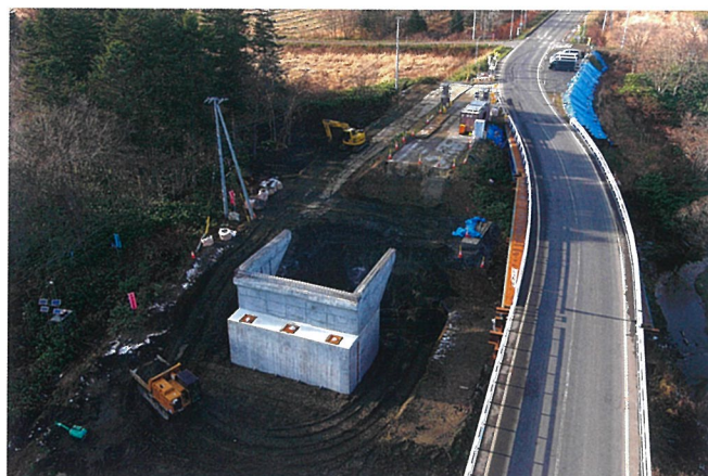
工事名：一般国道 40 号天塩町赤川橋下部外一連工事 工 期：2024.03.29～2025.02.11 発注者：留萌開発建設部
