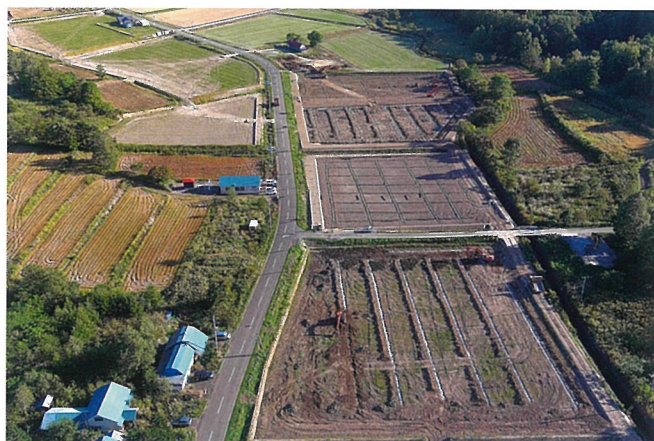
工事名：経営体朱文別外 1 地区 51 工区 工 期：2024.03.29～2024.12.20 発注者：北海道留萌振興局
