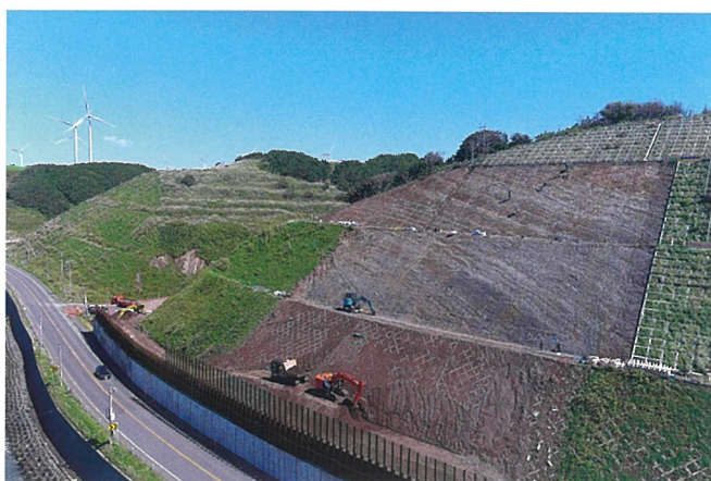
工事名：一般国道 232 号苫前町力屋防災対策工事 工 期：2024.04.05～2025.02.28 発注者：留萌開発建設部
