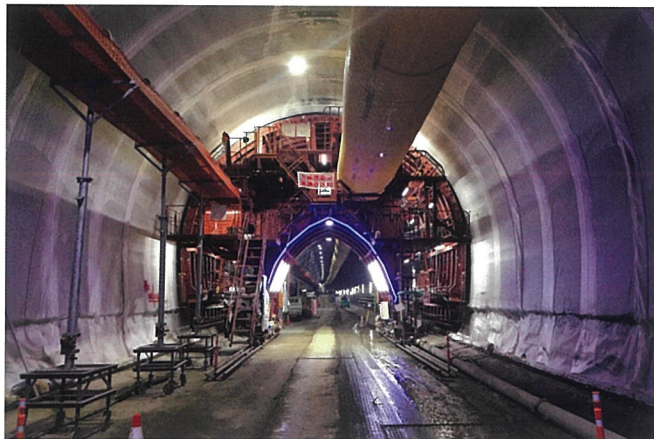
工事名：北海道新幹線、後志トンネル（天神）他 工 期：2019.11.01～2026.12.07 発注者：独立行政法人鉄道建設・運輸施設整備支援機構
