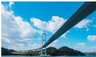
鉄筋を含むコンクリート床板の劣化状況診断
