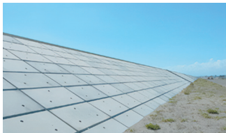
擁壁背面空洞調査・吹き付け法面空洞調査
