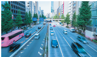
舗装内部の劣化状況の診断・ポットホールの調査
