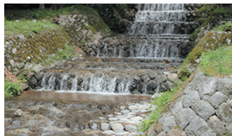
護岸背面の空洞調査・樋門、樋管背面の状況調査
