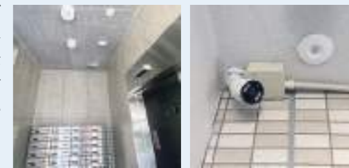
エントランス部分に設置済みの タレット型「VIGI C445」 各フロアに設置済みの パレット型「VIGI C345」
