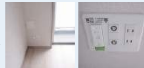
各部屋に導入済み AP「EAP615-WE-S」 SSID/PW が記載済みのため、即時ネット使用可能
